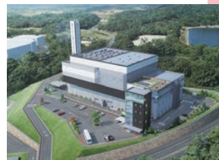
天理東インターの付近に建設中、新クリーンセンターのイメージ図
